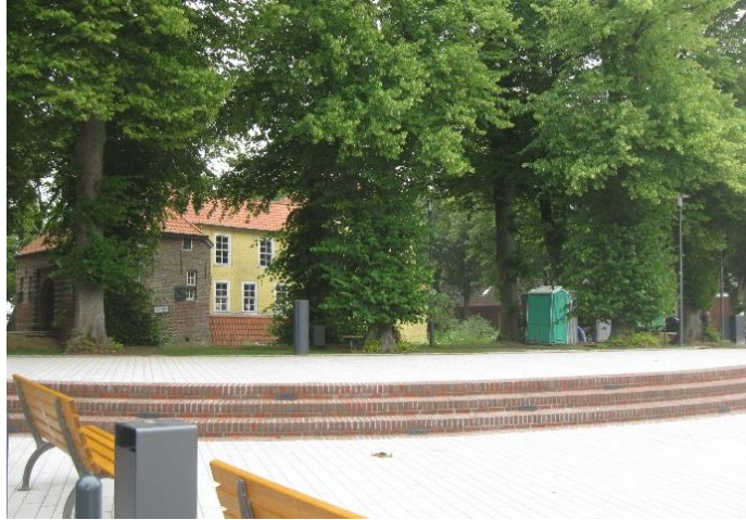
Blick auf die fertige Bühne des Marktplatzes
